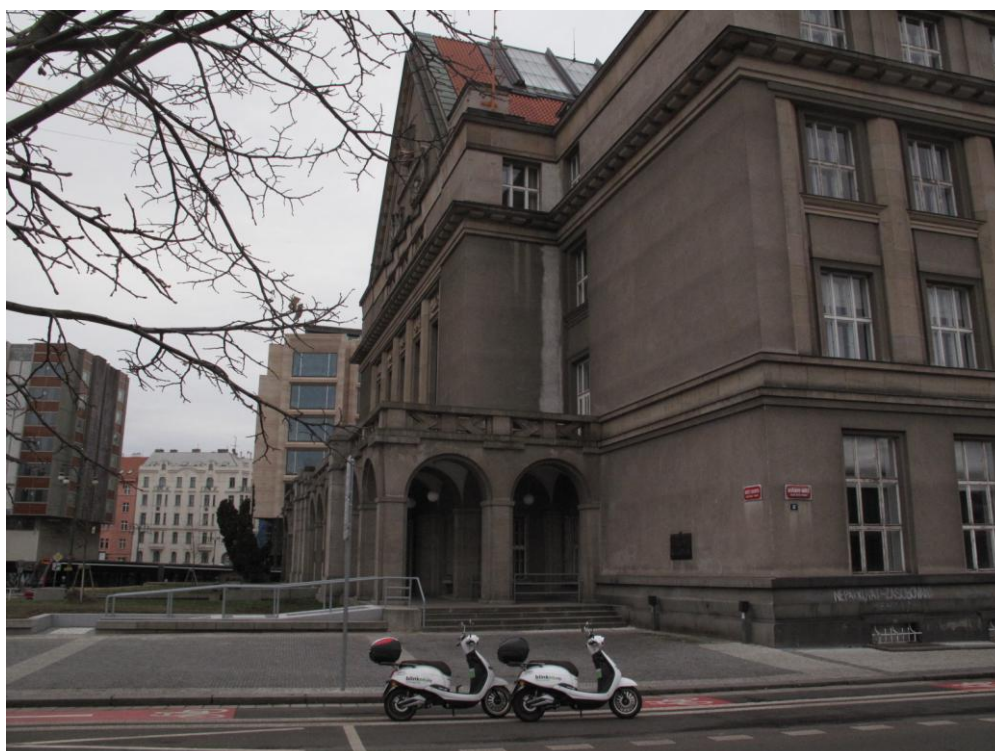
Nevhodné barevné sladění s původní omítkou a rozvlněná omítka do Dvořákova nábřeží
